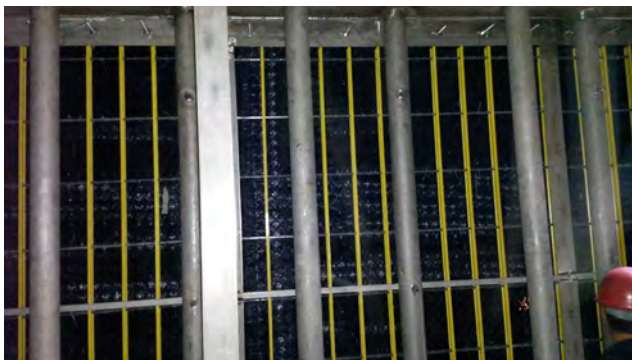
Рисунок 1. Сеточные прокладки BlueFil® из структурированного полипропилена, обрабатывающие выбросы гранулятора и охладителя до <math> < 30 \text{ mg/Nm}^3 </math>
